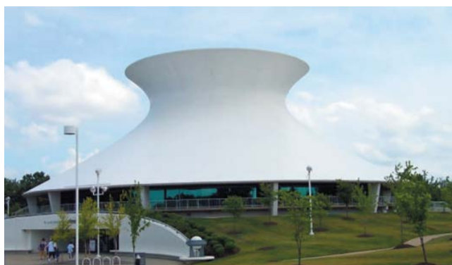
Рис. 17. Поверхня одно порожнинного гіперболоїду: a - градирні; б – планетарій.
