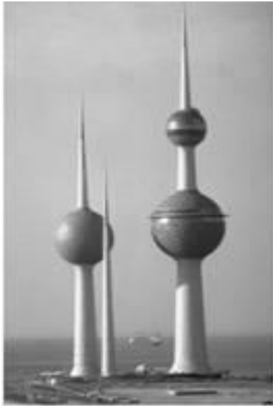
Рис.6. Водонапірна вежа, Кувейт, 1979р.
